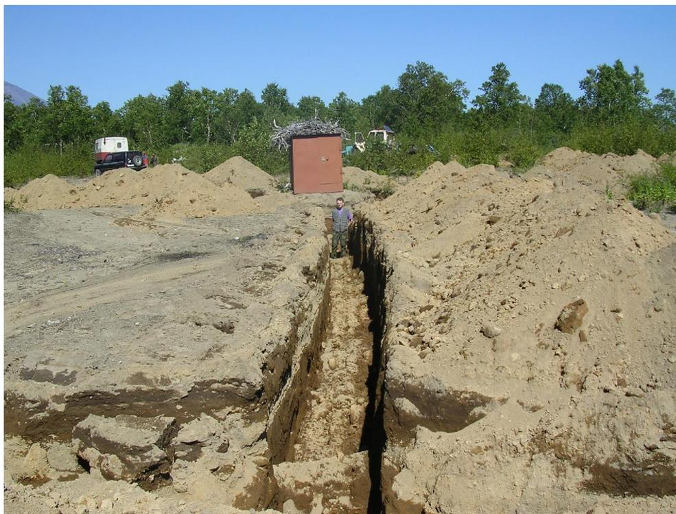
**Рисунок 2.21.** Рабочий момент работ по созданию подземной электрической антенны на базе скважины Р-2.
